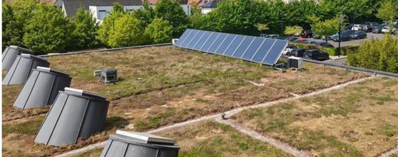
Panneaux solaires sur toit du siège social de Verspieren SA à Wasquehal
